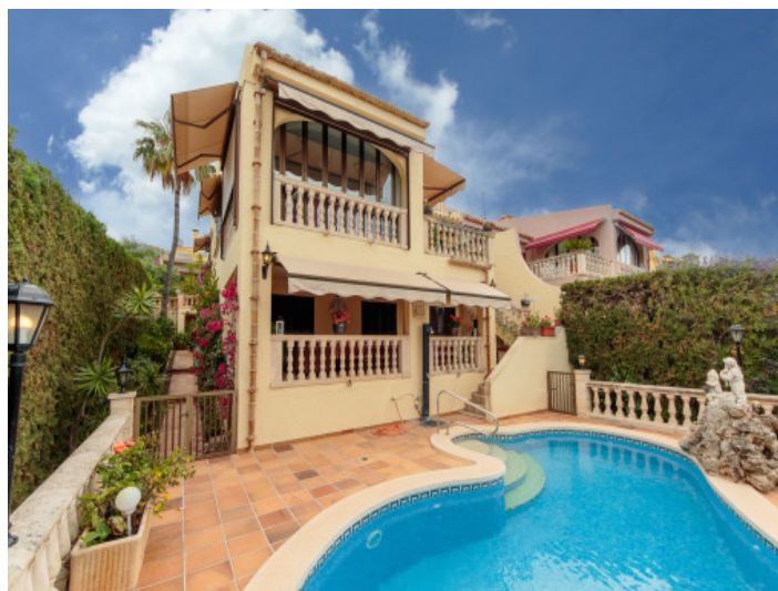
Fachada del chalet adosado
