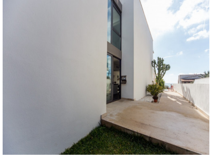
Entrada de la villa
