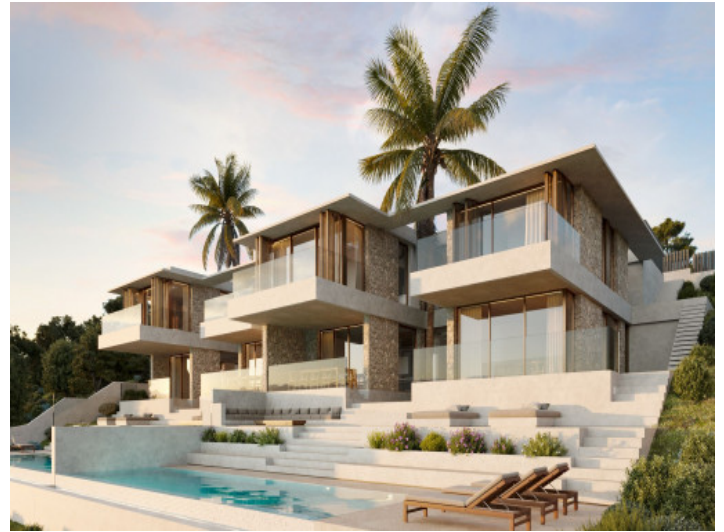
Vista exterior del proyecto
