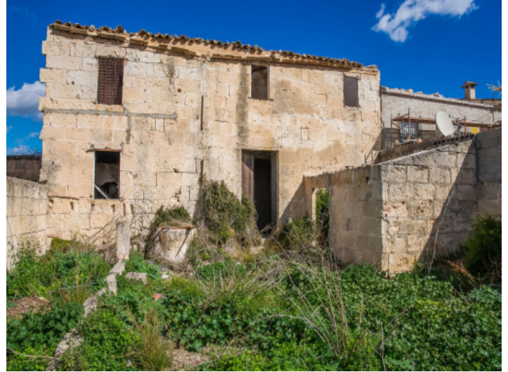
Casa de pueblo existente
