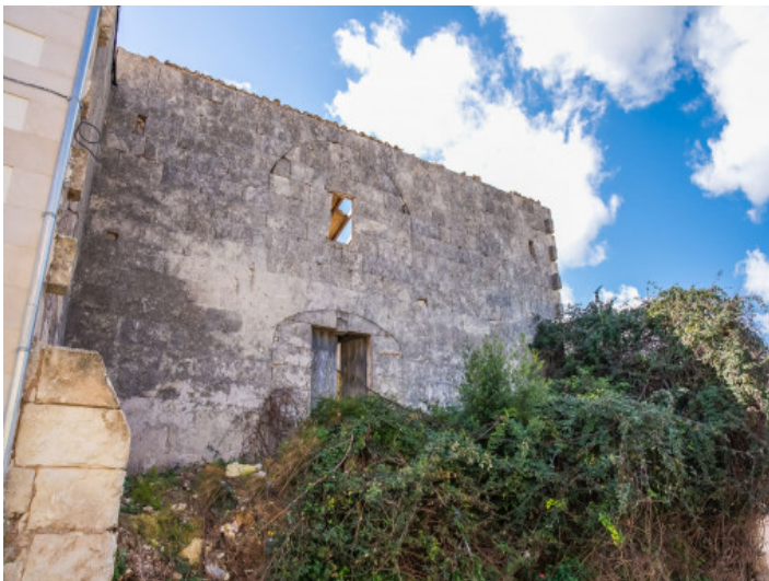
Fachada del norte
