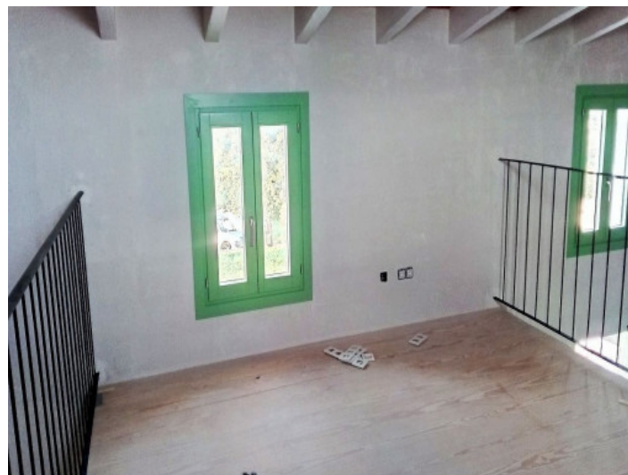
Galería en la planta superior
