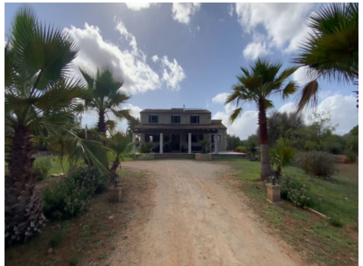
Camino de entrada
