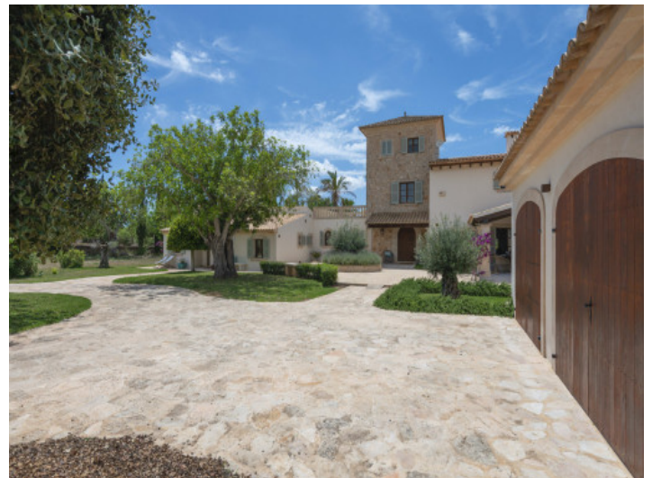
Vista exterior de la finca
