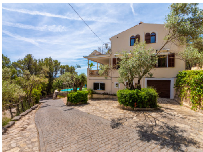
Fachada de la casa
