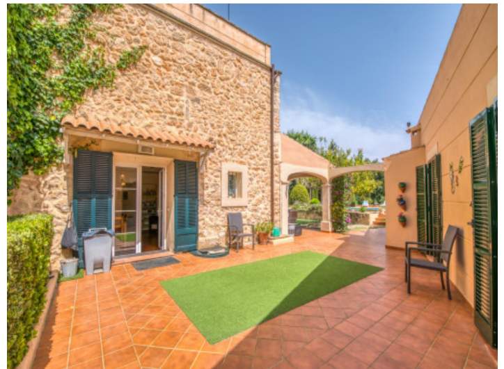
Casa principal a la izquierda y junto al edificio a la derecha
