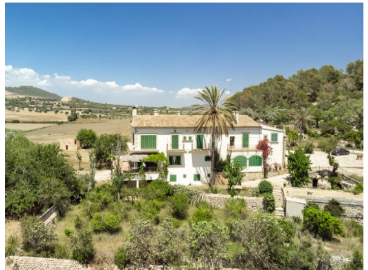
Vista exterior de la finca
