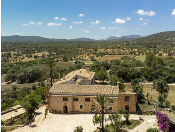
Vista exterior de la finca
