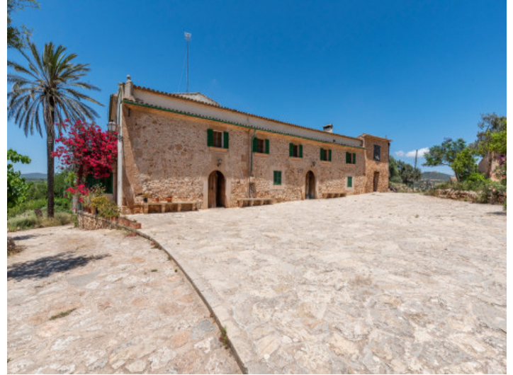
Vista exterior de la finca
