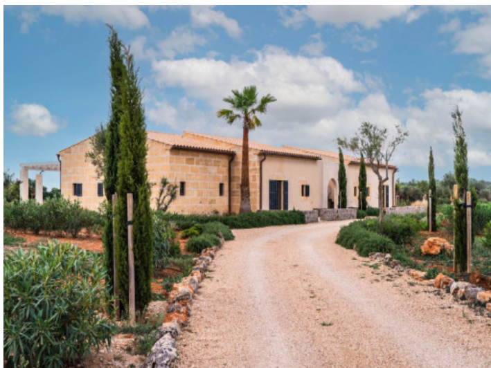
Camino de acceso a la propiedad
