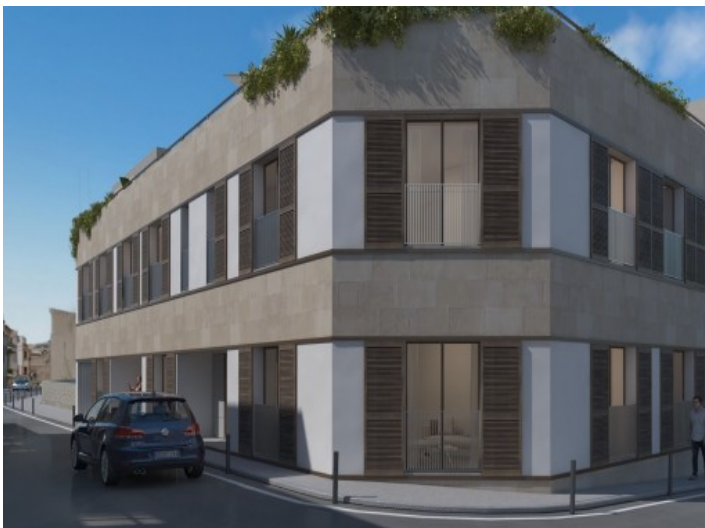
Vista exterior del edificio
