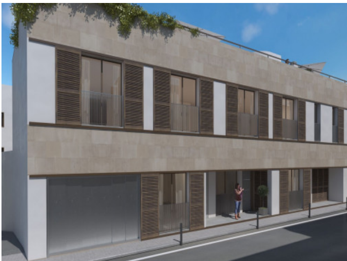
Vista exterior del edificio
