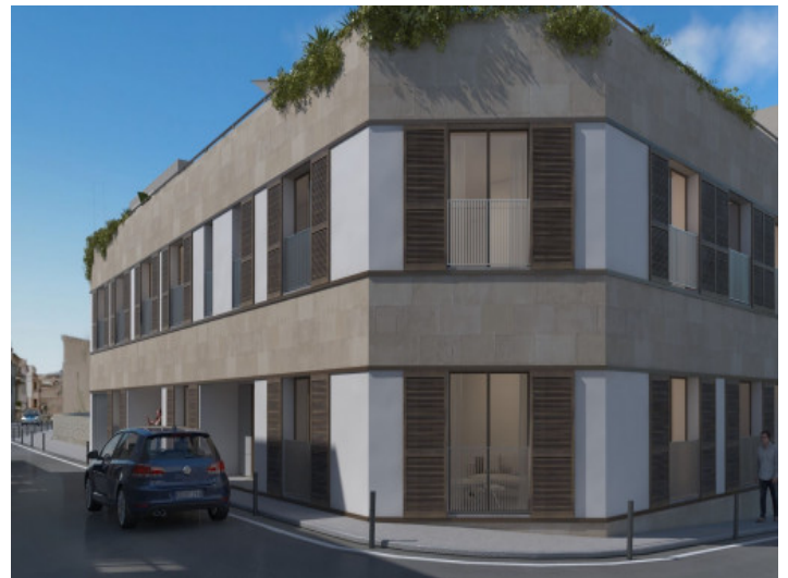
Vista exterior del edificio
