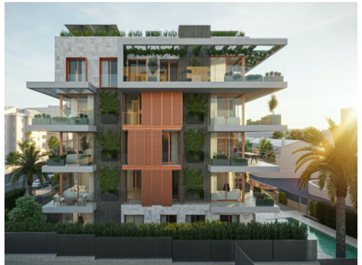
Vista exterior del proyecto
