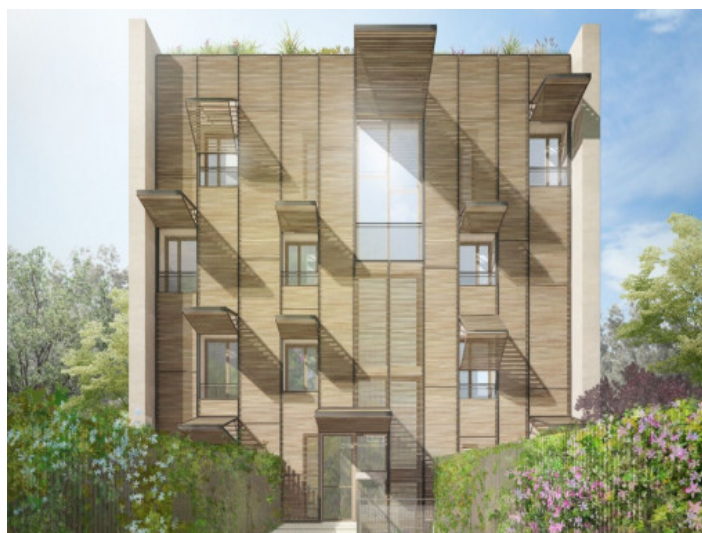
Vista exterior del complejo
