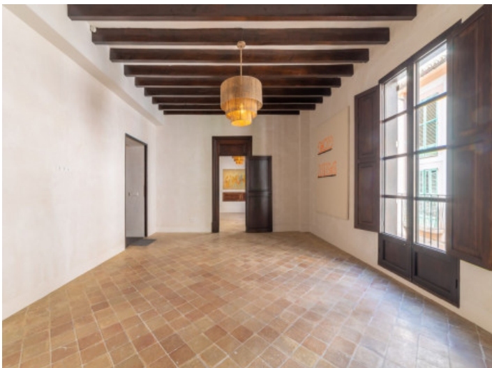
Vigas y baldosas originales
